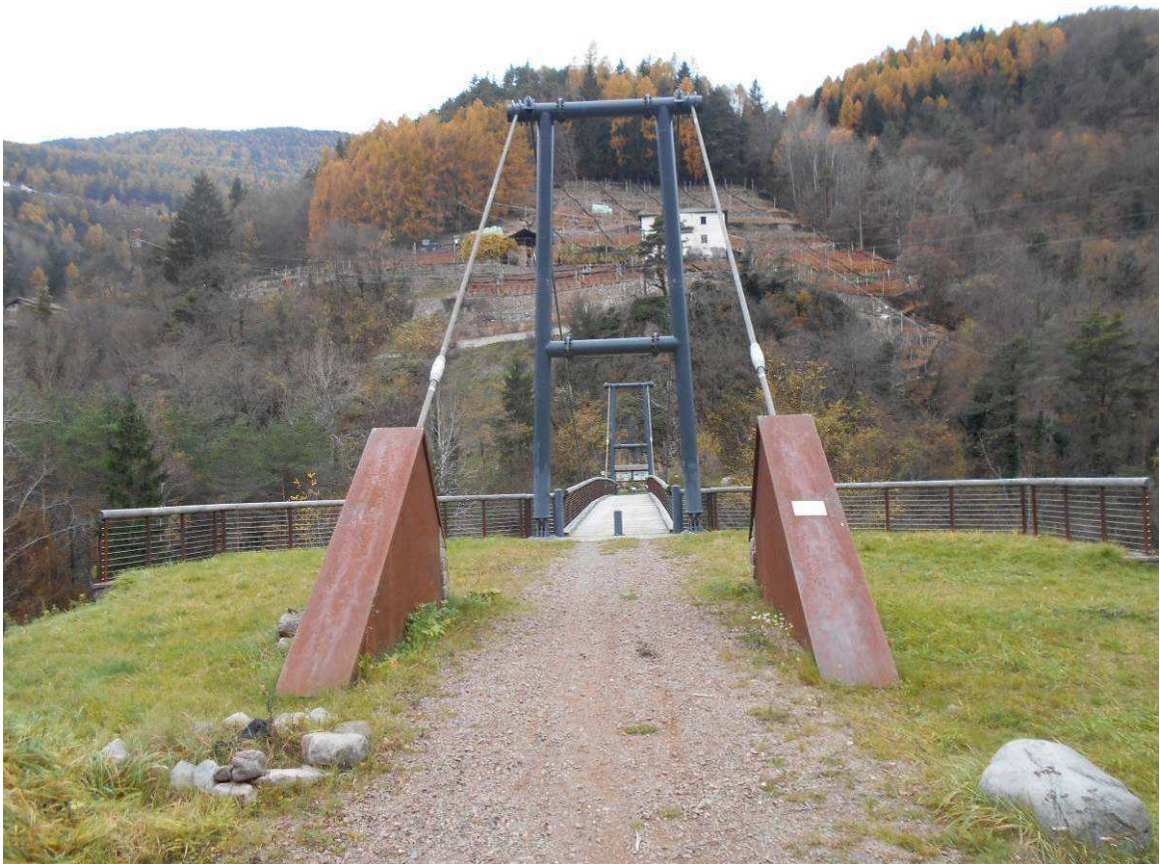
Il ponte di attraversamento del Torrente Avisio e le case de La Rio
