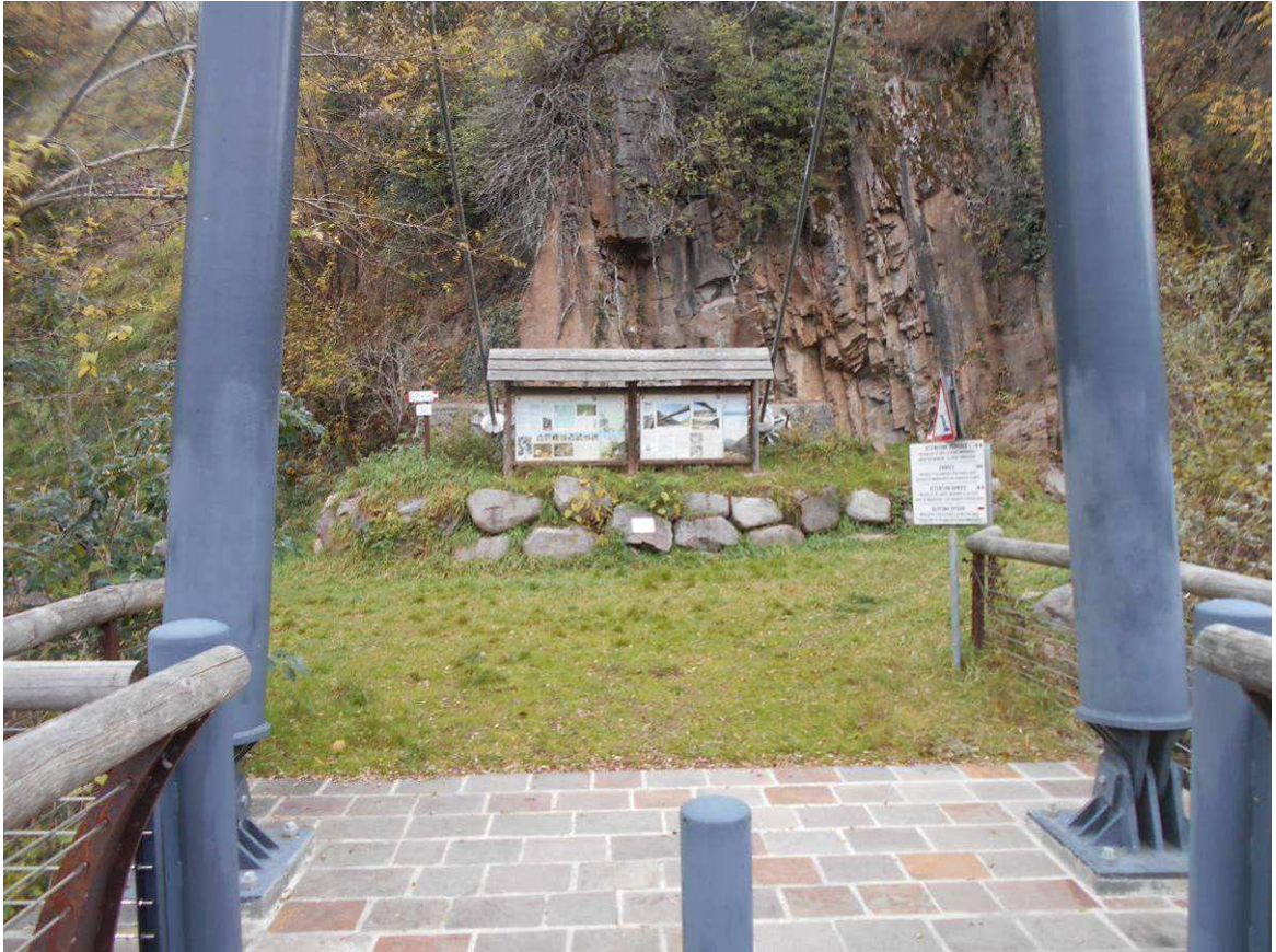
Il ponte di attraversamento del Torrente Avisio e la sua imposta sulla sponda di Grumes
